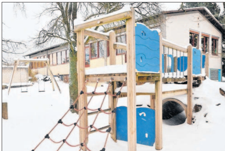
Der Spielplatz beim Kindergarten Esthal ist in schlechtem Zustand und kann neue Geräte dringend brauchen. Das Foto wurde Anfang dieser Woche aufgenommen.
